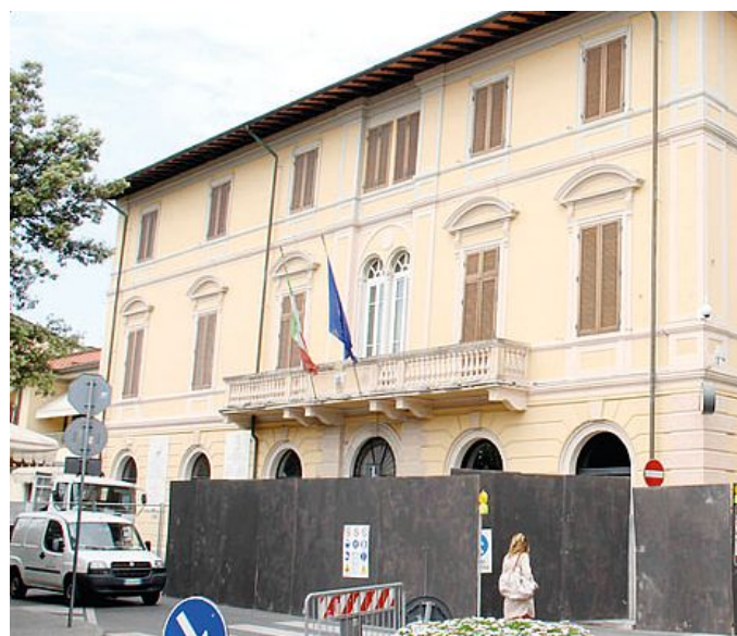
Il cantiere allestito a Palazzo Quartieri
